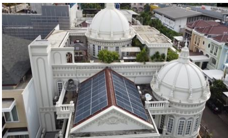
Gambar 2. Lokasi PLTS Atap
