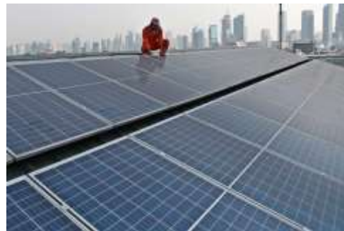
Gambar 6. Pemasangan PLTS Pada Gedung Pusat Dakwah di Jakarta [8]
