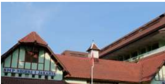
Gambar 5. PLTS Pada Sayap Kiri Gedung SMP Negeri 1 Cikini, Jakarta Pusat [7]
