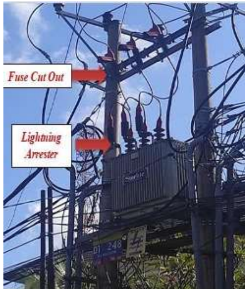
Gambar 3. Kontruksi Pemasangan LA Sesudah FCO
