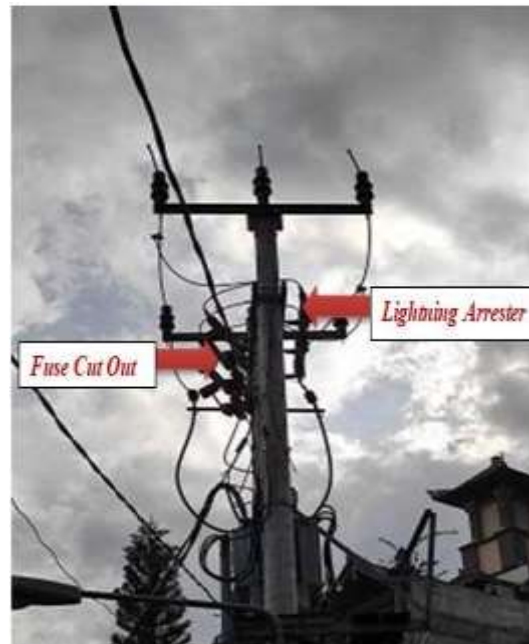
Gambar 2. Kontruksi Pemasangan LA sebelum FCO
