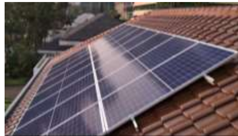
Gambar 1. Pemasangan PLTS Atap [8]
