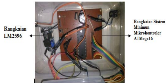
Gambar 8 Tampak Atas Bagian Dalam Rangkaian Penggerak Atap Kanopi.
