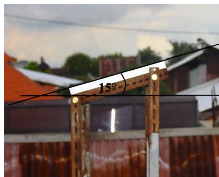
Gambar 5. Foto konfigurasi modul surya
