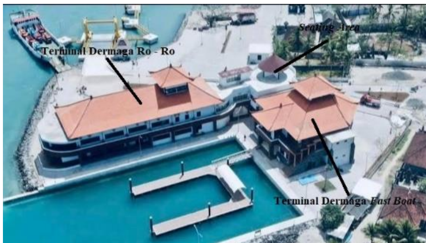
Gambar 1. Pelabuhan Penyeberangan Bias Munjul. Sumber : Pihak Kontruksi, 2021 (Dokumen Pribadi).
