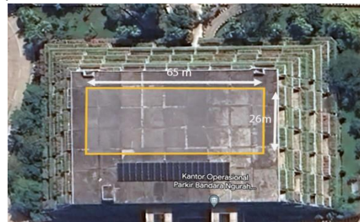
Gambar 3. Tampak Atas Gedung Parkir Bandar Udara I Gusti Ngurah Rai
