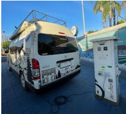
Gambar 2. EVSE pada Charging Station di Kota Denpasar [4]
