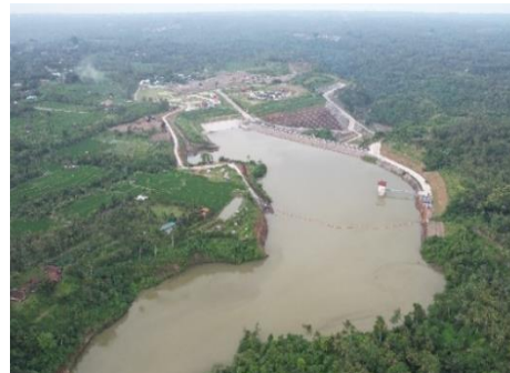
Gambar 2. Bendungan Tamblang Tampak Atas
