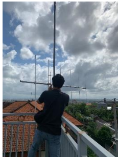
Gambar 15. Proses Pemasangan antena Yagi-LPDA di Kampus Bukit Jimbaran
