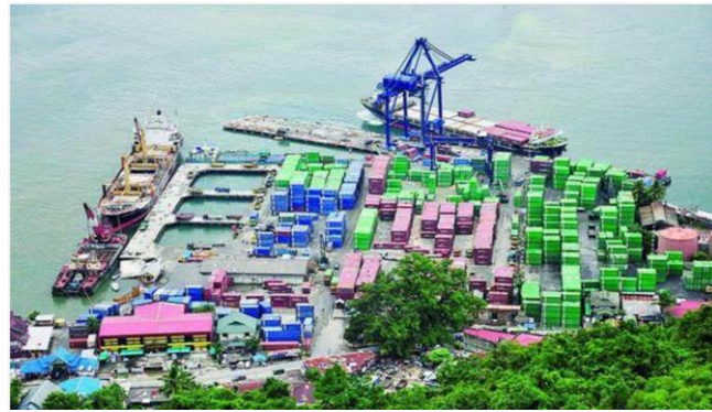
Gambar 1 Lokasi Pelabuhan Jayapura
