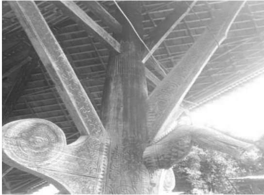
Gambar 8. Bangunan rumah adat Balla Tumuka di Tondok Bakaru
