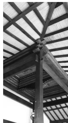
Gambar 8. Konstruksi Usuk pada Dudur Cocoa Bali Sumber: Observasi Lapangan 19/12/2017
