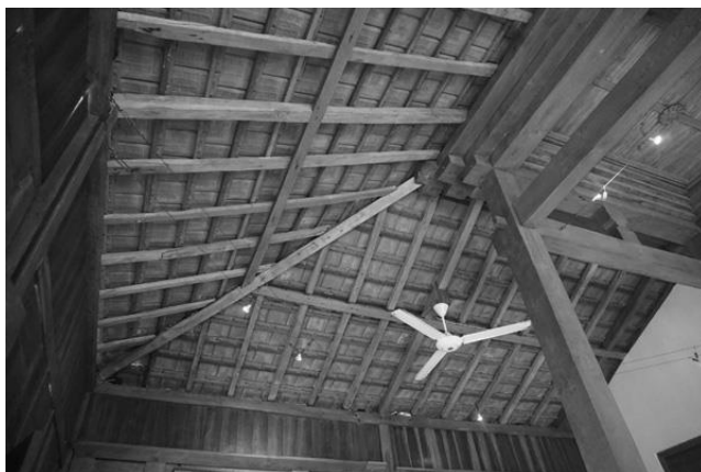
Gambar 7. Konstruksi Usuk pada Dudur Griya Joglo Sumber: Observasi Lapangan 12/01/2019
