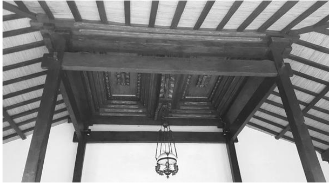
Gambar 6. Konstruksi Tikar diatas Usuk dan Apit-apit Sumber: Observasi Lapangan 19/12/2017
