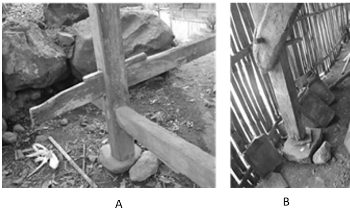
Gambar 2. Pondasi Tiang pada Batu Datar Uma Mbolo (A) dan Uma Ruka (B) Sumber: dokumentasi peneliti
