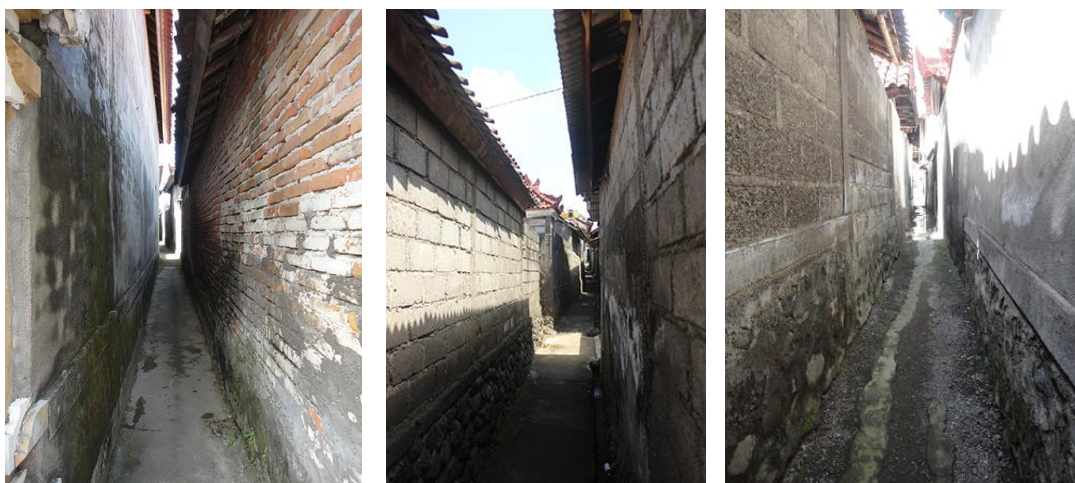
Gambar 5. Bata, Batako, Batu Tabas , Paras (merupakan material bangunan yang lazim dipergunakan saat ini)
