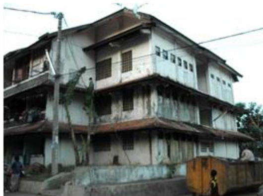
Gambar 5. Tampilan Gedung Rusunawa Kutobedah Malang
