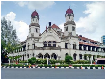
Gambar 1. Gedung Lawang Sewu pada Siang Hari Sumber: Dokumentasi Pribadi
