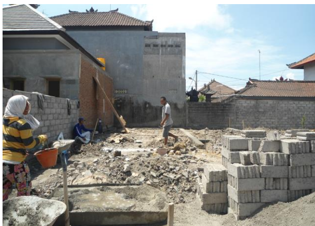
Gambar 5. Urugan bangunan dengan menggunakan bekas bongkaran bangunan Sumber: Hasil Observasi, 2017
