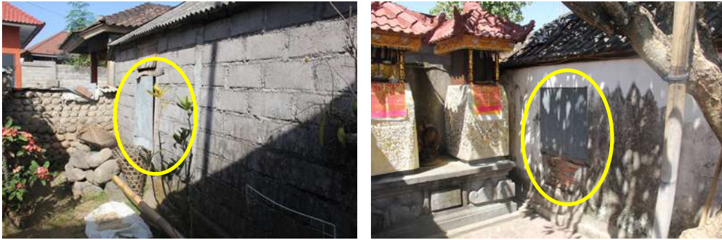
Gambar 6. Pintu / Lelompong Taksu pada tembok utara bale gede/ bale dangin
