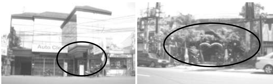
Gambar 3. Foto bangunan yang melakukan alih fungsi sempadan sebagai perluasan usaha. Sumber: Hasil pengamatan 2014.
