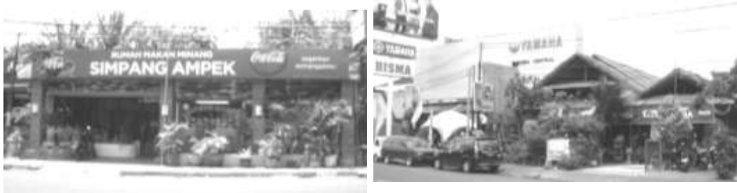
Gambar 9. Foto bangunan tempat usaha tanpa sempadan dan parkir. Sumber: Hasil pengamatan 2014
