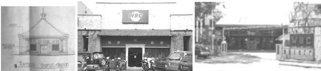
Gambar 5. Foto tampak bangunan pada lampiran dokumen IMB No. 790/2003 (kiri), realita tampak bangunan sampai tahun 2014 (tengah) dan perubahan lagi ditahun 2015 (kanan).
