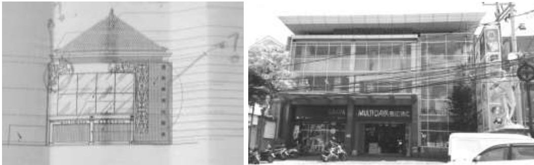
Gambar 6. Foto tampilan bangunan Graha Multi Daya Elektronik yang disetujui dalam dokumen IMB No. 1936/2011 (kiri) dan realita di lapangan (kanan).
