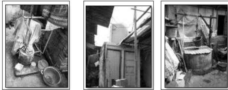
Gambar 11. Kondisi jaringan air bersih pada permukiman kumuh kasus 2 Sumber: Penulis
