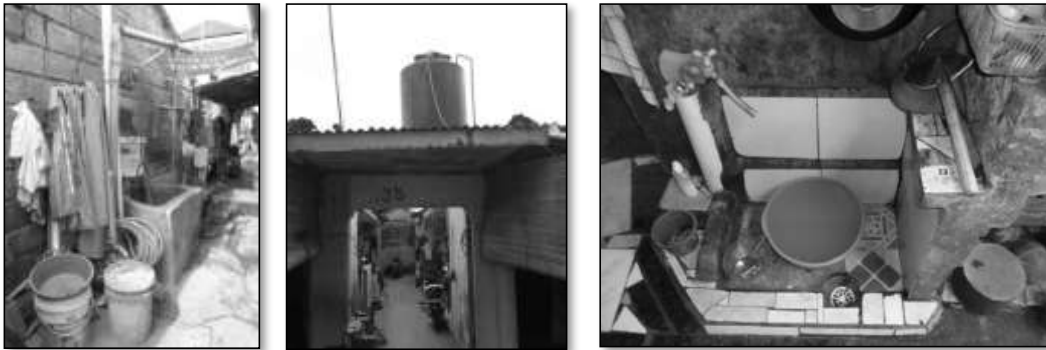
Gambar 16. Kondisi jaringan air bersih pada permukiman kumuh kasus 3 Sumber: Penulis
