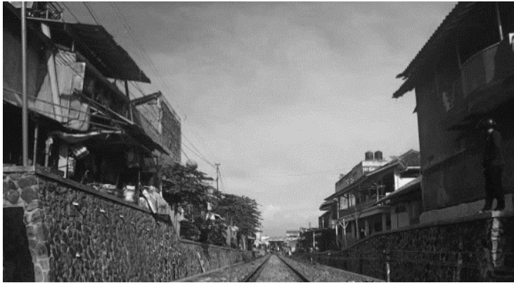
Gambar 1. Permukiman di Sempadan Rel Kereta Api Garut Sumber: Dokumentasi Penulis, 2023
