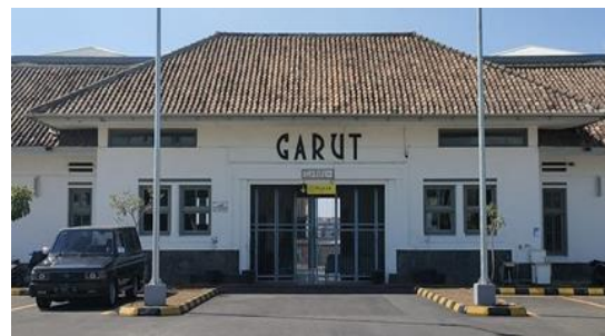
Gambar 10. Bangunan lama Stasiun Kereta Api Garut disebelah timur Kawasan Sumber: Ghani, H., 2021
