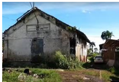
Gambar 13. Bangunan Lama Stasiun Pasirjengkol Sebelum Reaktivasi Sumber: Pratama, 2022
