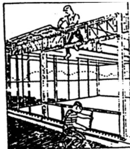
2. PENUTUPAN STRUKTUR DENGAN CLADDING
