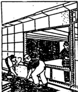
3. PEMASANGAN PANIL DINDING DAN KUSEN
