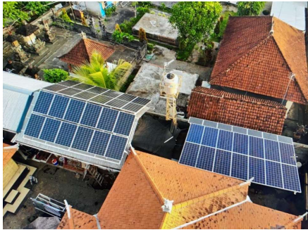
Gambar 2. Tampak atas PLTS
