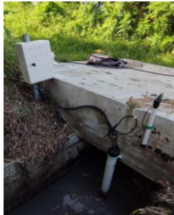
Gambar 6 : Pemasangan Alat Monitoring Air Limbah
