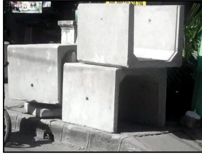
Gambar 5. Salah Satu Contoh Tipe Potongan Saluran Drainase
