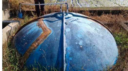
Gambar 2. Desifulizer penyimpan biogas
