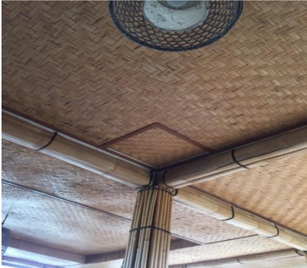
Gambar 1. Bedeg yang sudah terpasang
