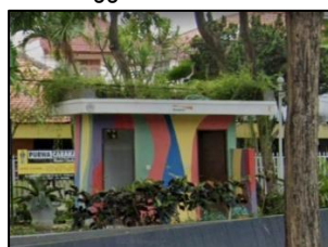
Gambar 8. Toilet Taman Janggan
