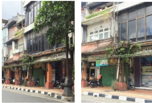
Gambar 7. Kondisi Keindahan Jalur Pedestrian
