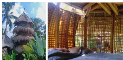
Gambar 2. Atap Teritis Menjuntai; dan Dinding Ber-Rongga dari Rotan Sebagai Pengkondisian Termal
