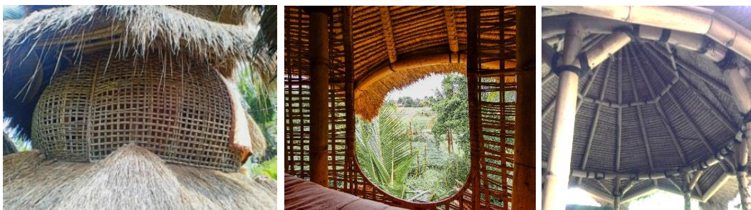
Gambar 4. Rongga antara ruang dan atap yang tinggi mendorong sirkulasi udara yang maksimal
