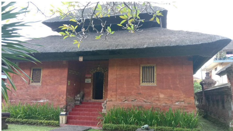
Foto 2. Gedung Tabanan yang mewakili arsitektur tradisional khas Bali Selatan (Foto: Anom H.S.)
