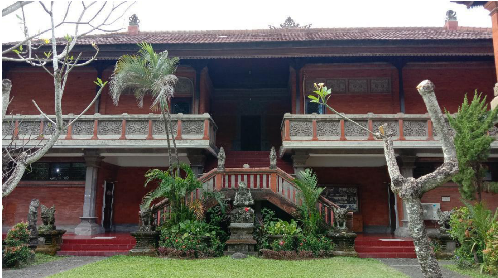
Foto 5. Gedung Timur yang terdiri atas 2 lantai tanpa fasilitas naik untuk pengunjung penyandang disabilitas (Foto: Anom H.S.).
