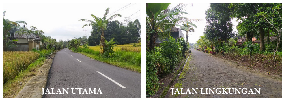
Foto 11. Kondisi jalan utama dan jalan lingkungan Desa Bongkasa Pertiwi (Foto: Bayu Anggawirya).
