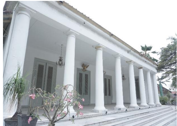
Gambar 8. Gedung ex Kersidenan Banten / ex Musium Negeri Banten. Sekarang menjadi Gedung Negara. Sumber: Peneliti (2020).
