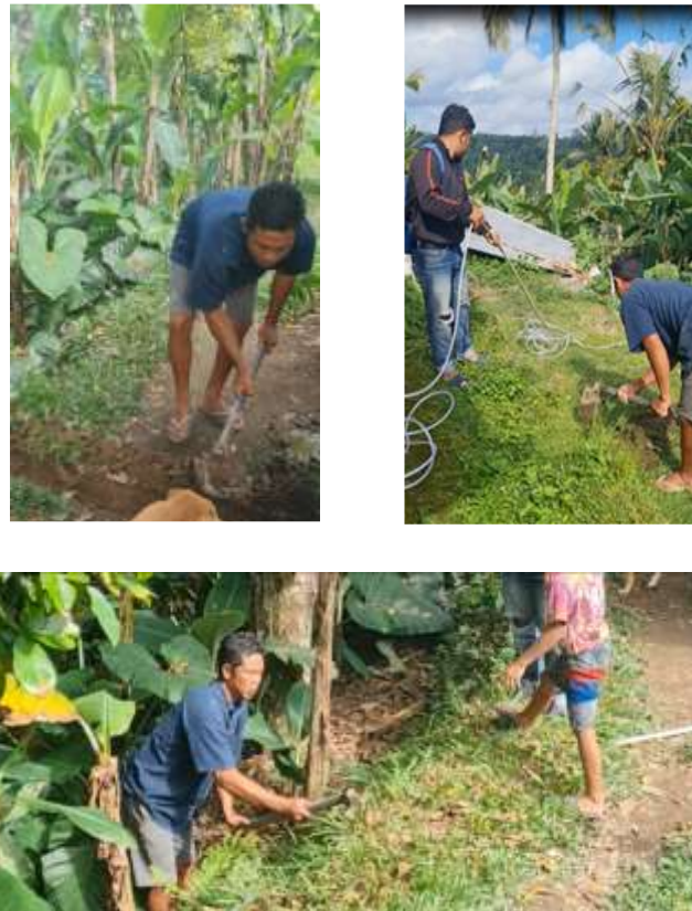
Gambar 2.3. Pemasangan selang biogas dari degister ke kompor gas
