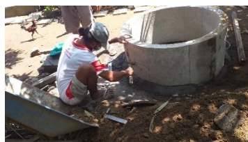
Gambar 3.7 Pembuatan sumur biopori dan lubang biopori percontohan di rumah Bapak Ngakan Nyoman Suarsana, Banjar Pagutan, Desa Banjarangkan
