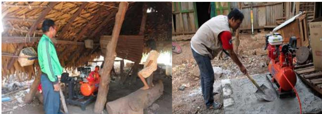
Gambar 3.3 Penyerahan dan Pemasangan Alat
