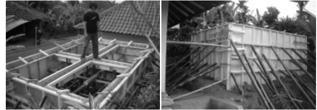
Gambar 8. Pembuatan reservoir baru.
