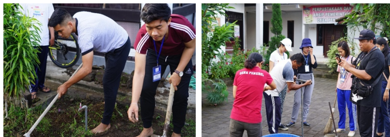
Gambar 3.1. Proses Pengeboran Lubang Resapan Biopori
