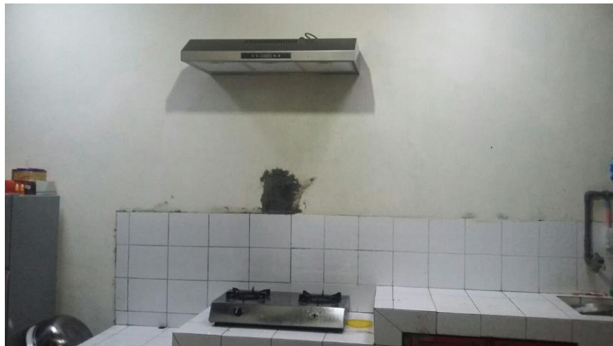
Gambar 3. Pemasangan Exhaust dan Pembuatan Meja Ergonomis
