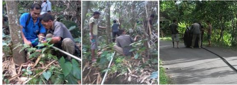
Gambar 8. Pemasangan Pipa Tekan pompa
