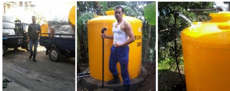
Gambar 9. Pemasangan Bak Penampungan Air
