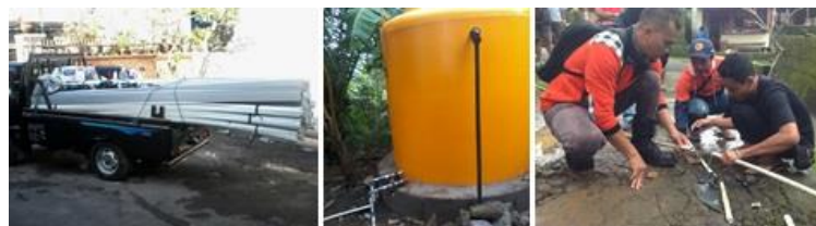
Gambar 10. Pemasangan sistem gravitasi
