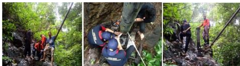
Gambar 12. Perbaikan sistem pompa hydram di Dusun Pateh
