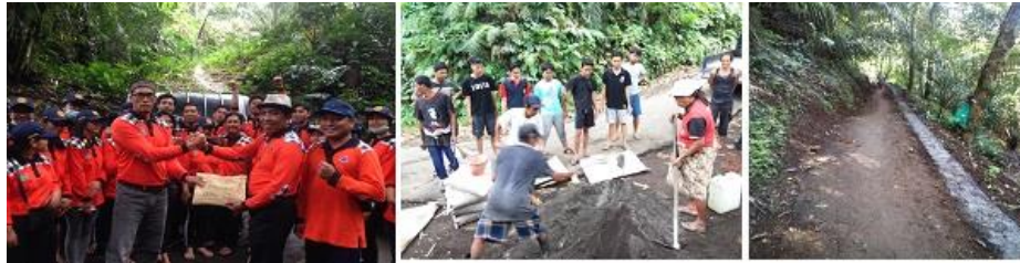
Gambar 15. Persiapan pengerjaan tangga menuju air terjun Jaga Satru
