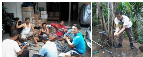
Gambar 11. Pengerjaan sistem sambungan rumah
