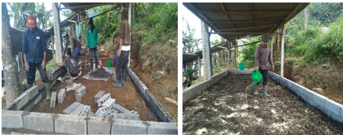
Gambar 1. Pendampingan pembangunan rumah vermikompos.
