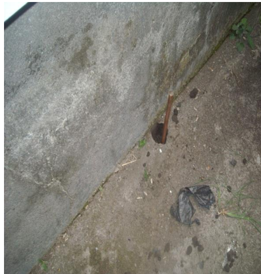
Gambar 4.2 Foto Kegiatan Pemasangan Pembumian
