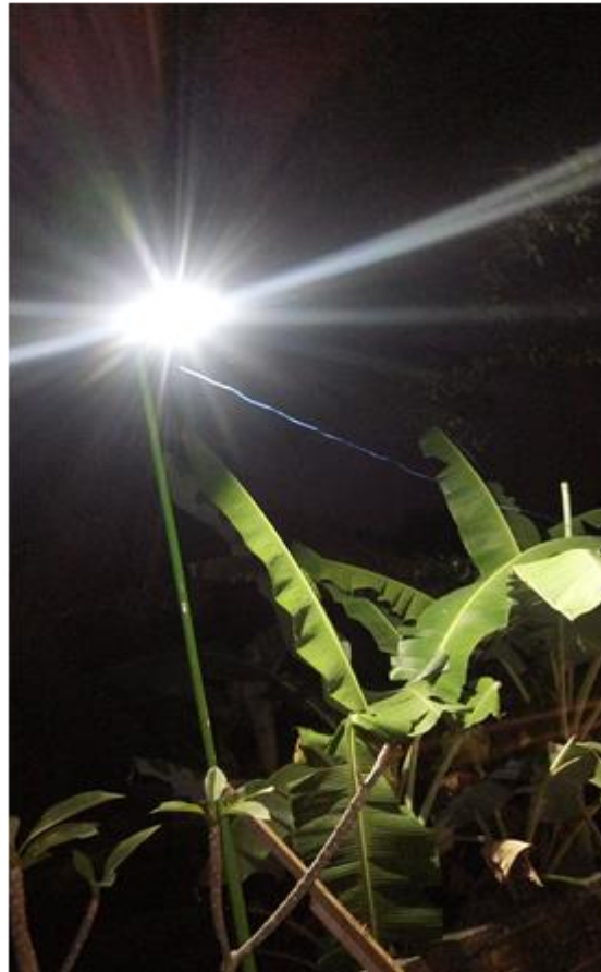
Gambar 4.1 Foto Hasil Pemasangan Instalasi SWER
