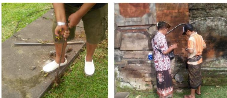
Gambar 3.1. Kabel yang terlalu banyak sambungan dan kabel NYM yang bukan untuk kabel luar
