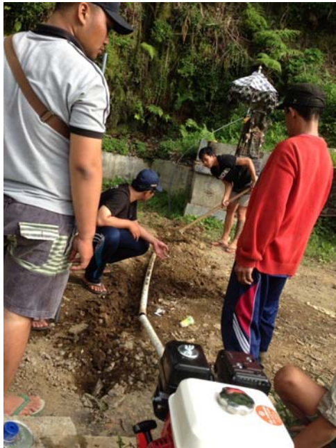
a. Pemasangan Mesin Pompa
