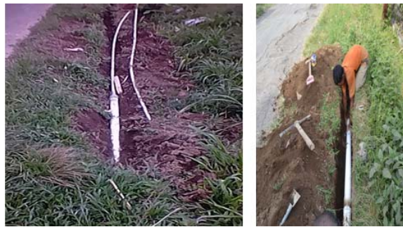
Gambar 3. Pemasangan pipa air metode gravitasi
