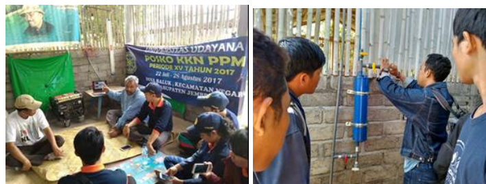
Gambar 3.2. Penyuluhan, Pemasangan desulfurizer dan genset biogas
