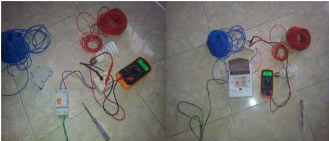
Gambar 2. Pemasangan peralatan pengaman arus sisa, ELCB 1 phase pada perlengkapan hubung bagi
